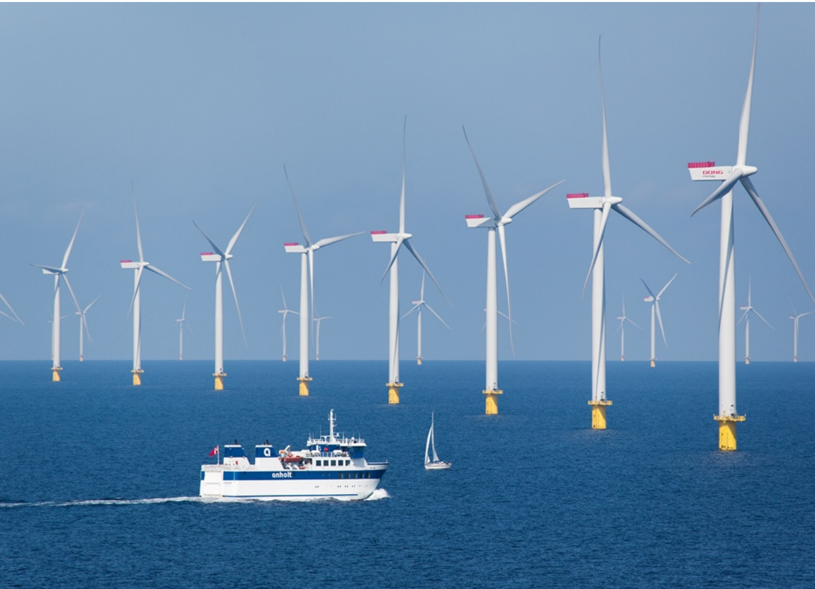
Anholt (Denmark) Parque Eólico Offshore 400 MW
