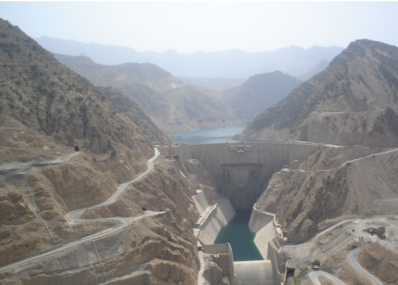
Karun-3 Dam, Irão 2 280 MW, 185 m de altura de queda
